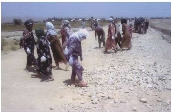
Планировка откосов дамб и сбор крупных камней, для последующей укладки железобетонных плит. Район Весе, Джамоат М.Вайсов, село Ходжа-Галтон
