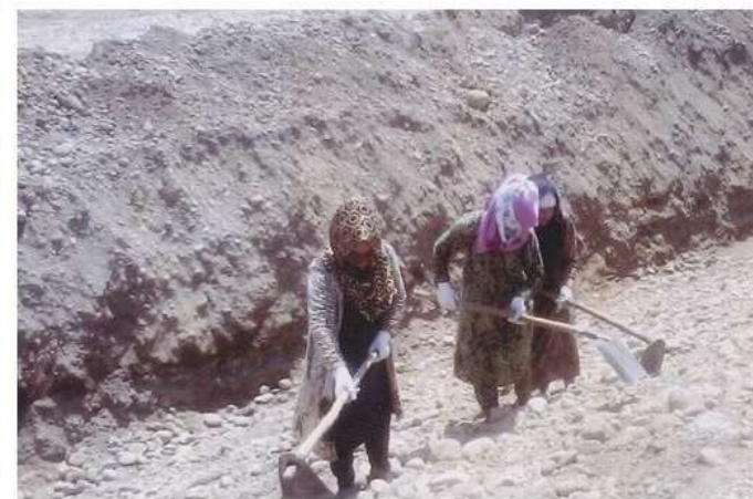
Планировка откосов дамб и сбор крупных камней, для последующей укладки железобетонных плит. Район Весе, Джамоат М.Вайсов, село Ходжа-Галтон
