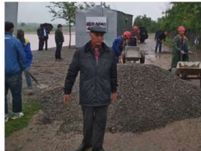
Профилирование гравием подъездной дороги.
